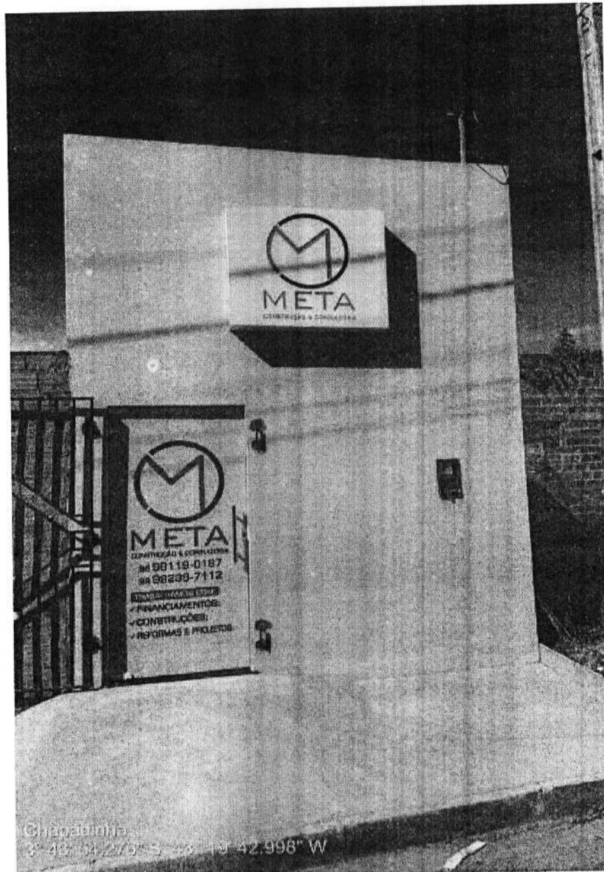
Imagem 1- Fachada Georreferenciada lat.3°43'54.276" long. 43°19'42.998"
